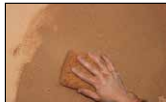
Étape 4 - une fois l'enduit sec, passage d'une éponge semi-humide afin de faire tomber les poussières de surface et faire ressortir le lin.
